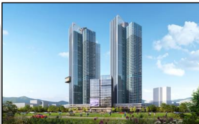
연산동 아라비안나이트 주상복합 신축공사
