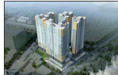
온천장지역주택조합 주상복합 신축공사
