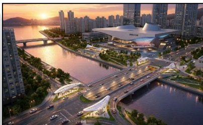
영화의전당 지하차도 건설공사
