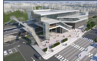
경부선 구포역 증축공사
