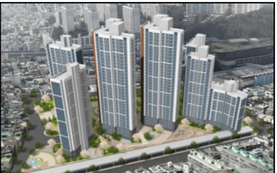
수영구 망미동 공동주택 신축공사
