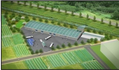
구미 가축분뇨 공동자원화시설 조성사업
